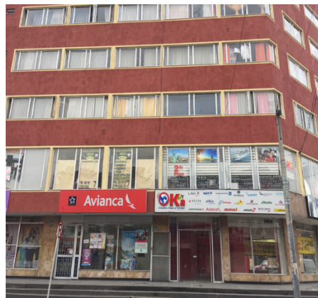
Fotografía No. 3: Panorámica del Aviso del establecimiento OKA ASESORIAS ESTUDIOS VIAJES Y TURISMO S.A.S., ubicado en la Calle 15 Sur No. 17 – 44 Oficina 211, elemento tipo aviso en fachada instalado y publicidad en ventanas.
