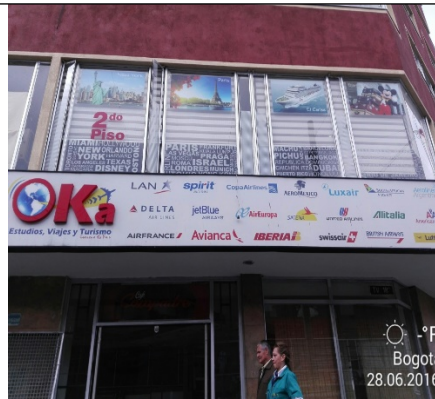
Fotografía No. 2: Panorámica del Aviso del establecimiento OKA ASESORIAS ESTUDIOS VIAJES Y TURISMO S.A.S., ubicado en la Calle 15 Sur No. 17 – 44 Oficina 211, elemento tipo aviso en fachada instalado y publicidad en ventanas.
